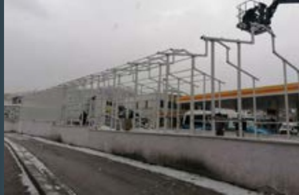
İşyeri Muhafaza Yapıları
